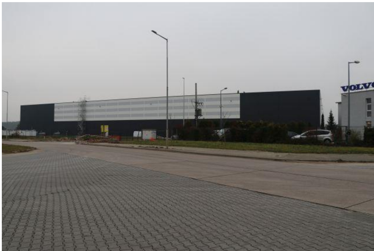
Widok na obiekt w budowie, na terenie o symbolu 3U-P
