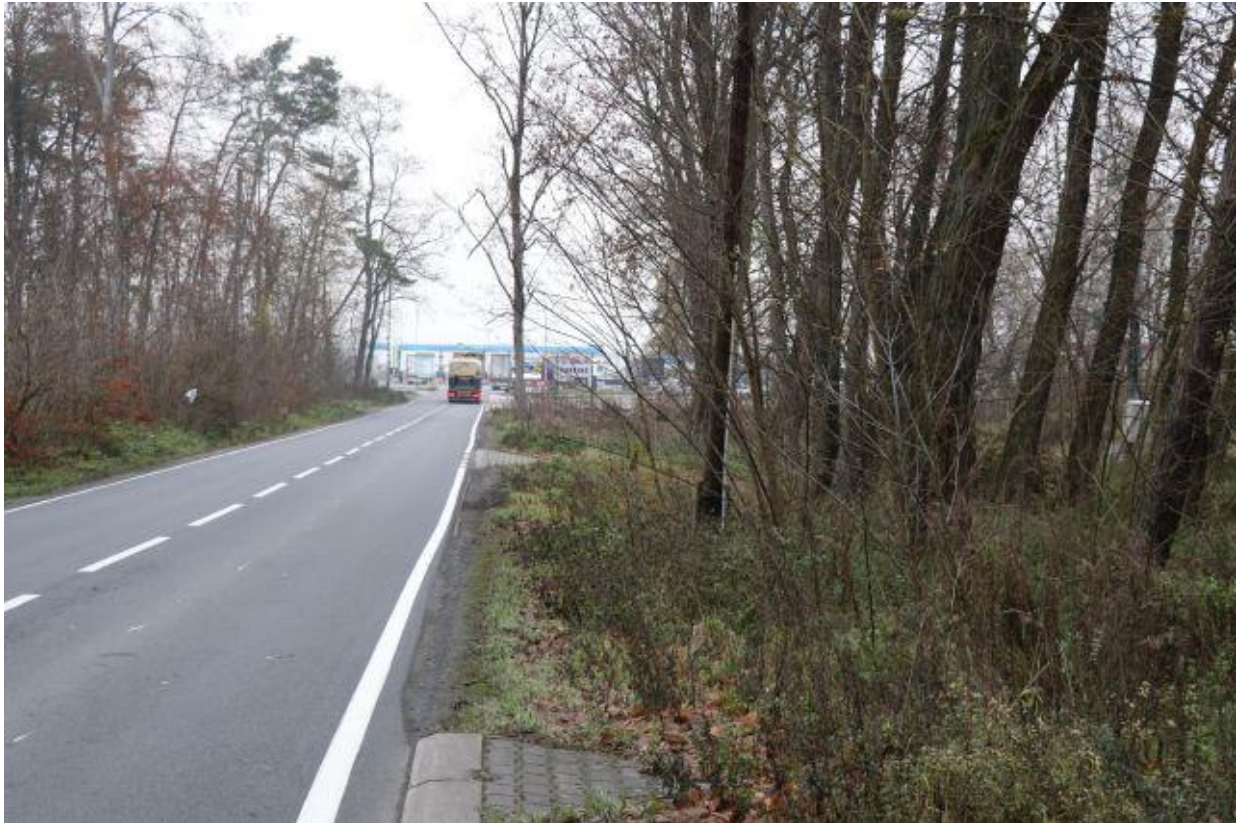
Widok na teren opracowania od strony południowej – wjazd na teren
