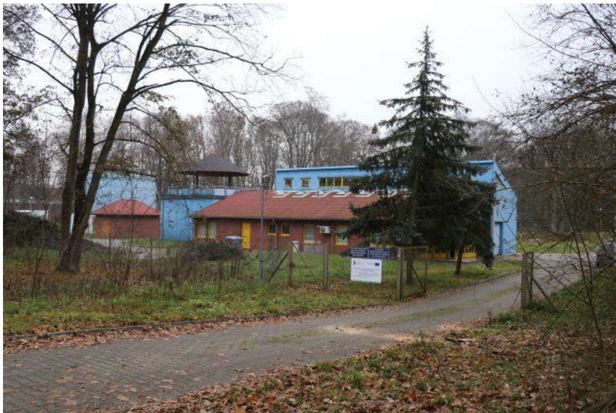
Widok na stację uzdatniania wody – dz. nr ew. 74/14 (poza obszarem m.p.z.p.)
